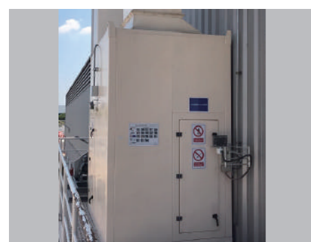
Paint mist filter collection system (VOC gas activated carbon adsorption system) 塗料ミストフィルター回収方式 (VOCガス活性炭吸着)
